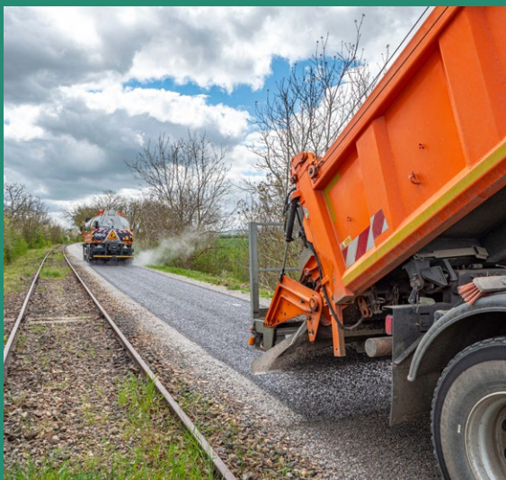
Ce chantier avait pour objectif principal la réhabilitation d'une voie désaffectée de 17 km entre Gannat et Saint-Pourçain-sur-Sioule.
