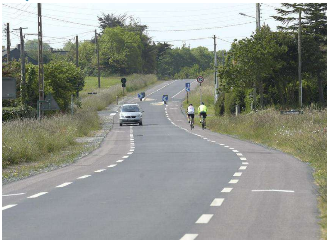
Photo de couverture : une CVCB dans les Côtes d'Armor
