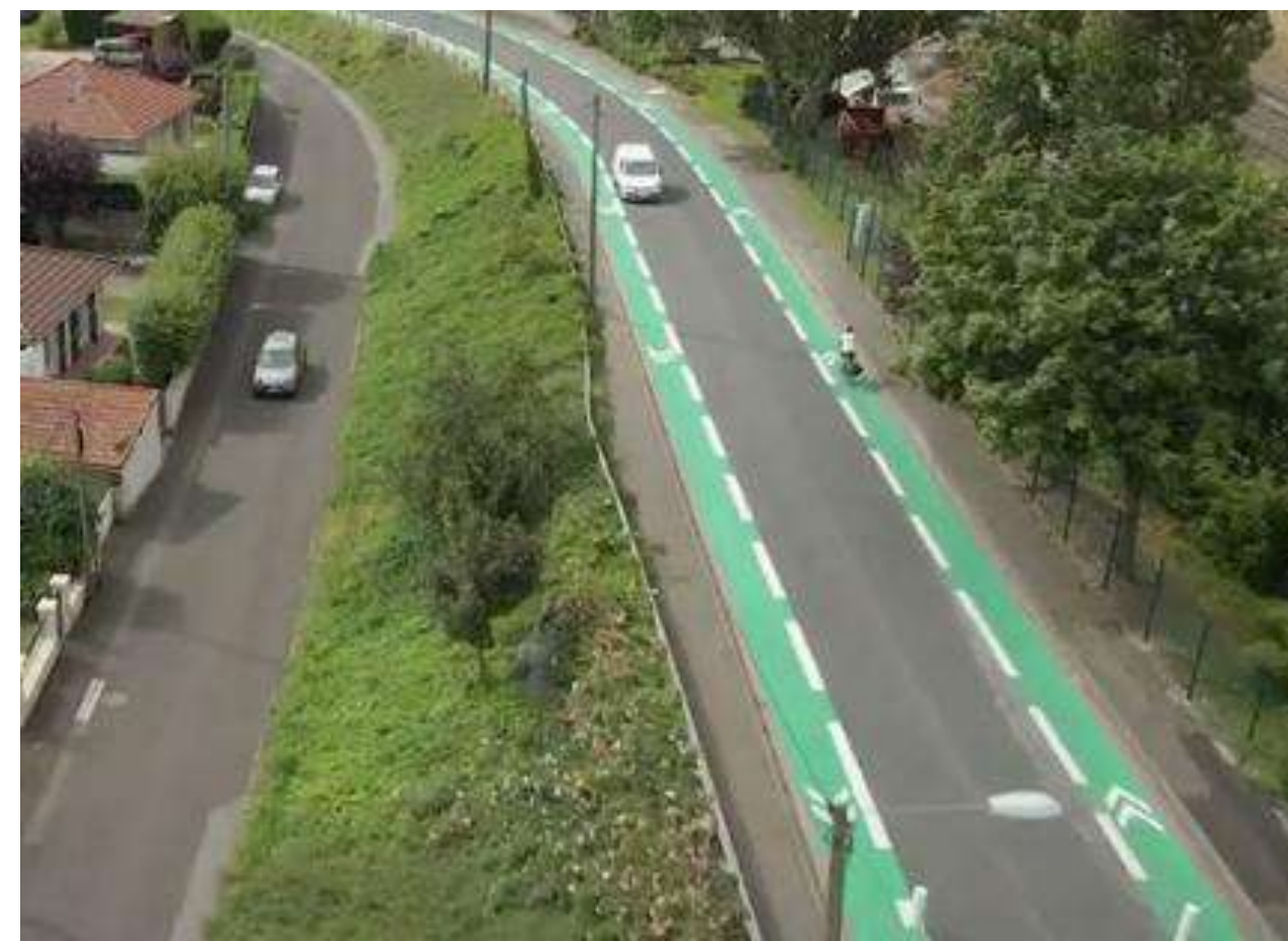
CVCB sur un pont à Riom (Puy de Dôme)
