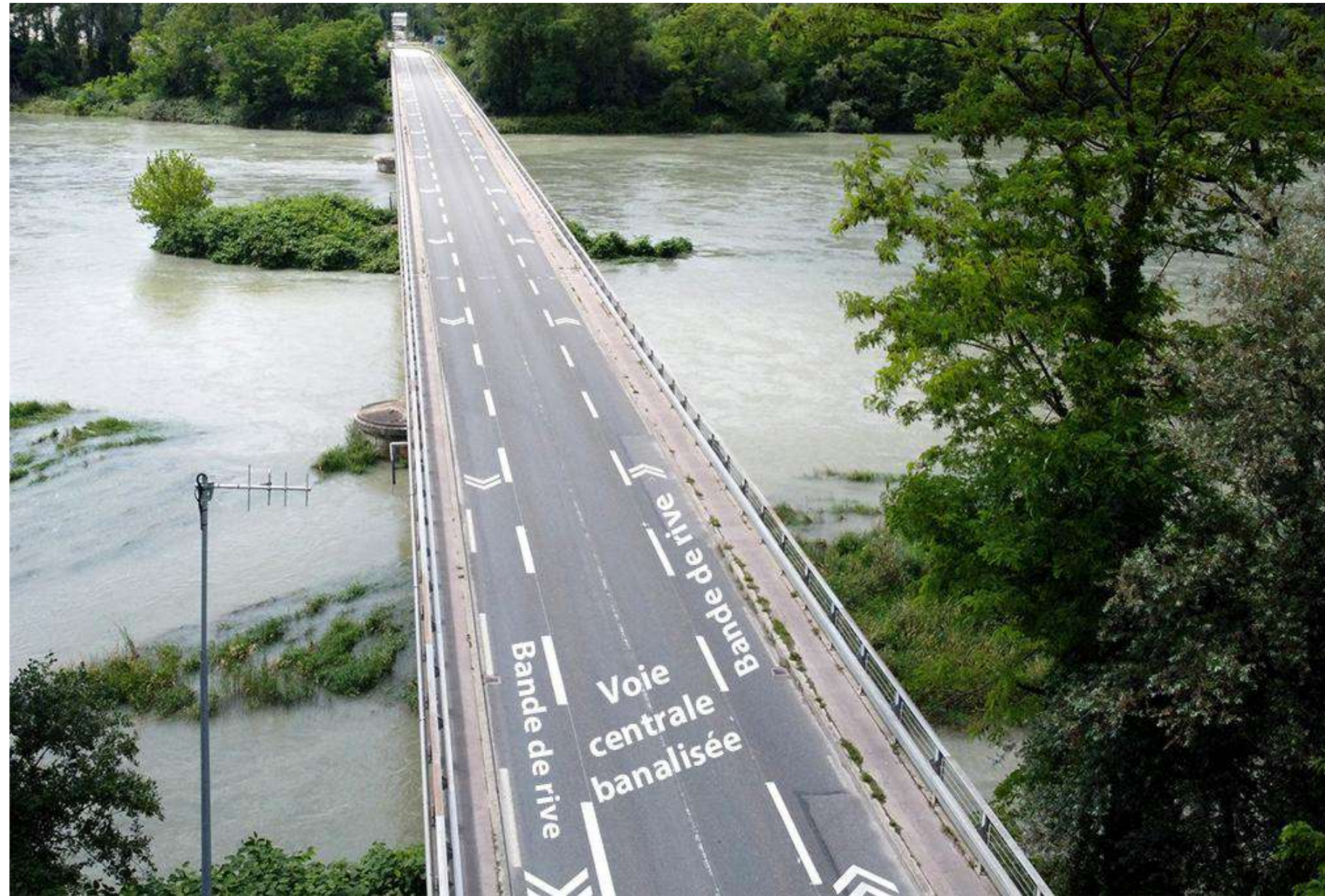
Sur les ouvrages d'art : ici le pont de la Loi à Ruffieux (Savoie)
