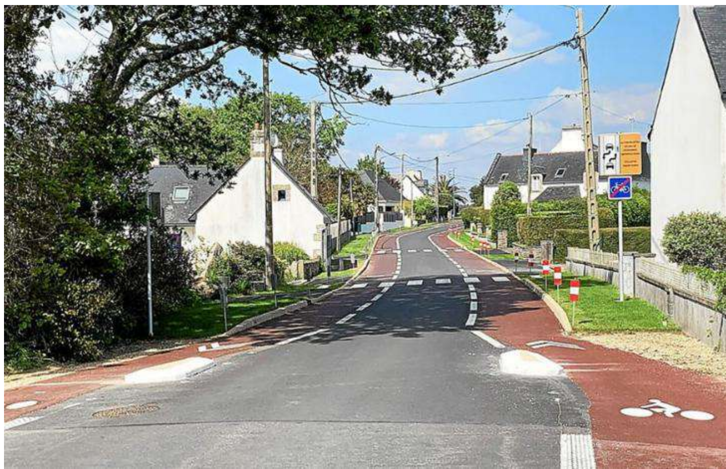
CVCB à Trégunc (Finistère)
