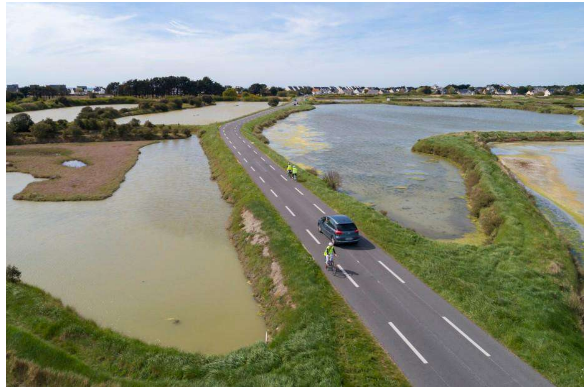
Entre des marais, sur une digue : ici D92 entre Guérande et La Turballe (Loire-Atlantique) Crédits photo : Département de Loire-Atlantique
