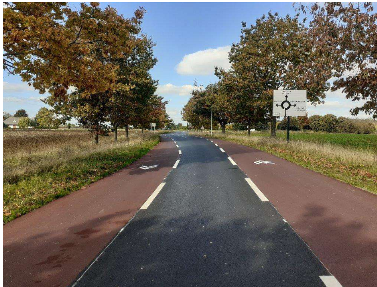
CVCB sur la RD19 entre Templeuve-en-Pévèle et Fretin (Nord)
