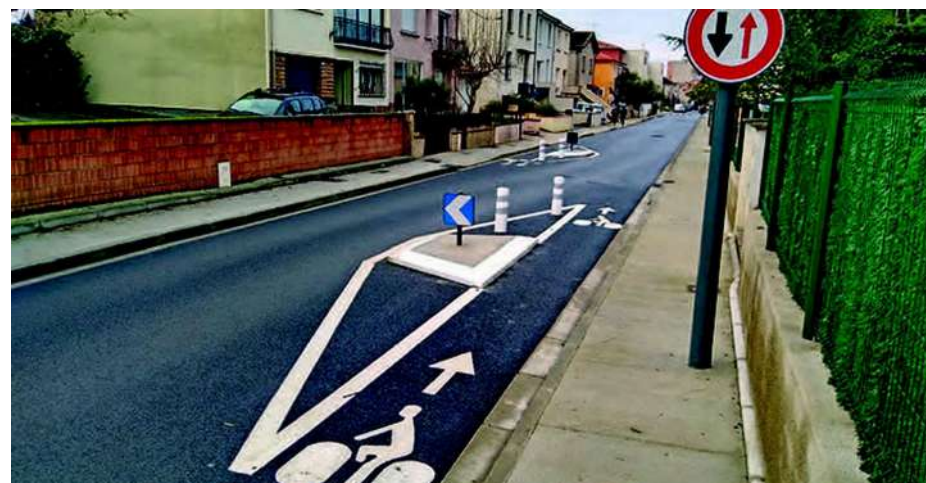
Exemples d'écluses avec by-pass cycliste
