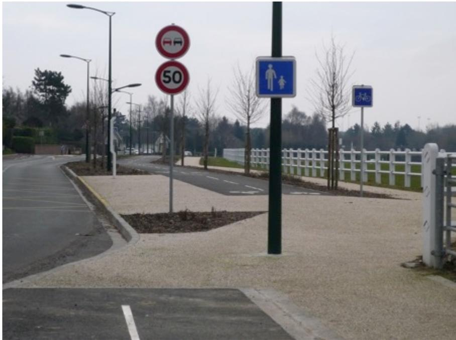
*Exemple d'une interruption ponctuelle d'une piste cyclable bidirectionnelle du fait d'un rétrécissement : un espace partagé est signalé par une indication d'aire piétonne.*
