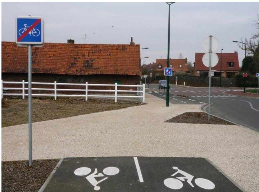
*Cas d'une piste bidirectionnelle interrompue au droit d'un rétrécissement. La mixité est de mise et signalée par un panneau d'aire piétonne.
